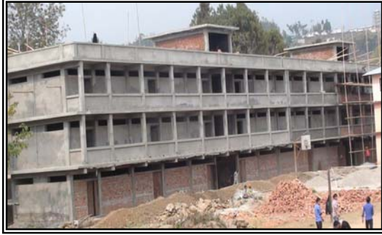
भारतीय दुतावासको सहयोगमा निर्माणाधीन भवन ।
