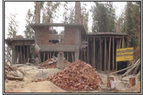
निर्माणाधीन पुस्तकालय भवन
